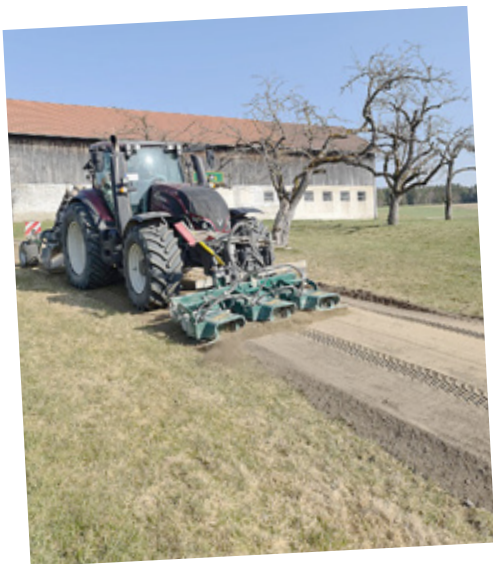
Wegebau mit Valtra T214 und Rüttelplatte in der Front sowie gezogenem Grader im Heck.
